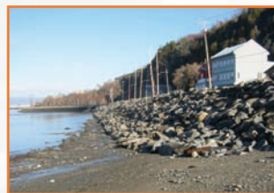
Bank protection • Baie-St-Paul, rivière du Gouffre
